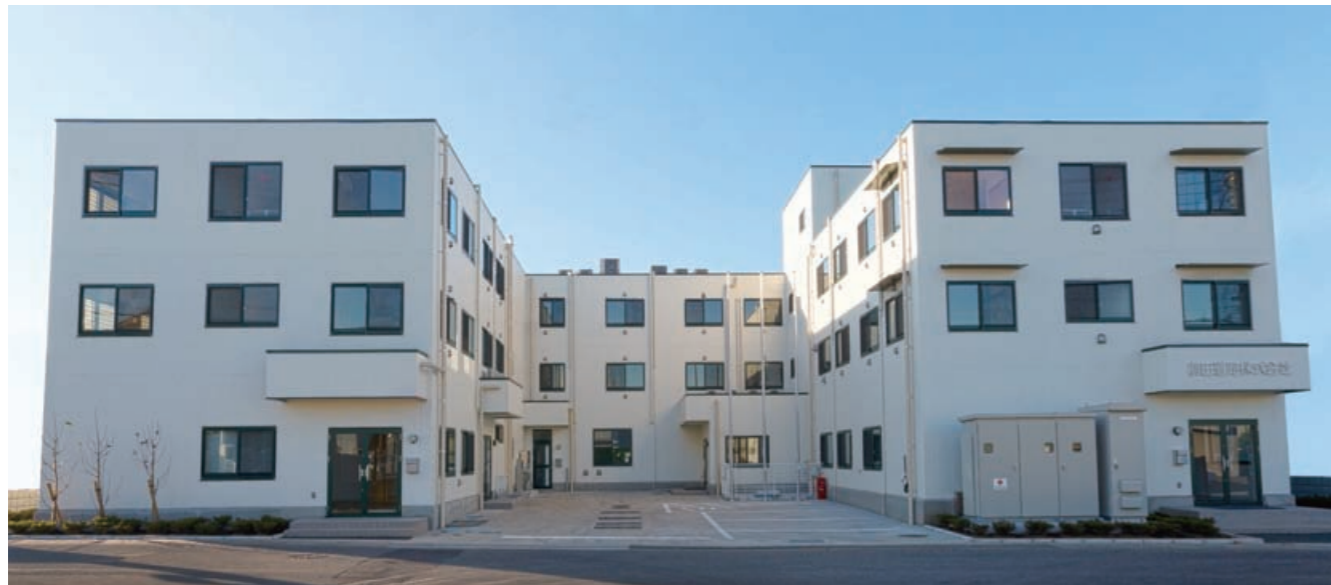
武蔵野営業所全景 (埼玉県新座市)
